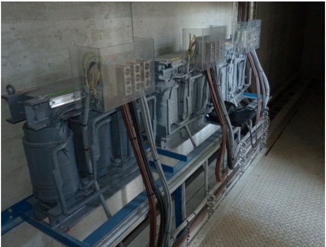
Abbildung 42: 40V Transformatoren Belagsheizung Hiltalingerbrücke
