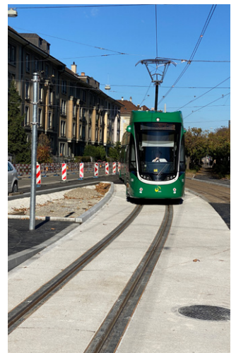
Abbildung 16: Feste Fahrbahn Margarethenstrasse nach der Erneuerung im Jahr 2021
