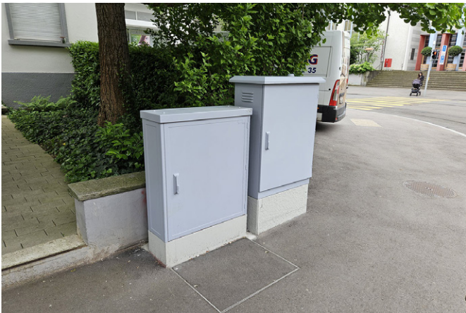
Abbildung 39: Schmieranlagensteuerung und Elektroverteilung Zwinglihaus
