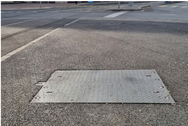
Abbildung 38: Bodenkasten der Schmieranlagensteuerung Nr. 85 beim Kunstmuseum
